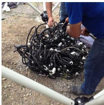
En la imagen, se muestra la malla, la cual debe ser desenredada para poder situar los conectores en posición para la instalación.
