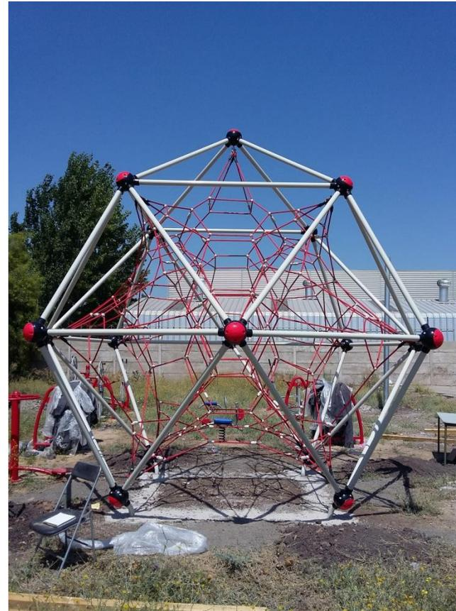
En la imagen, se muestra el juego con la malla instalada y en proceso de otorgar tensión a cada conector de a uno a la vez y por polos opuestos.
